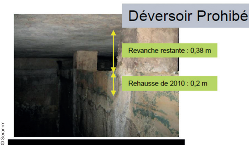
Figure 8. Revanche résiduelle à la suite de la rehausse sur le déversoir Prohibé. La revanche est l'espace libre restant pour permettre le déversement des eaux. Le déversoir Prohibé est celui de la station de pompage appelée "Prohibé".
