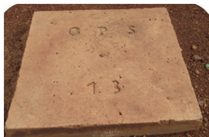
Figure 4. Borne GPS N° 13 du réseau géodésique national de 1 er ordre (dimensions 1 m x 1 m x 1 m).
