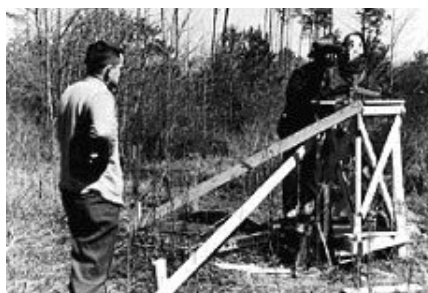
1953 : Geodimeter 1 - Durée de la mesure : 2 à 3 heures - Résultats : obtenus au bout d'une heure de calcul Prisme requis.
