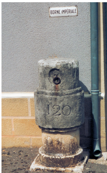
Fig. 12 : La borne milliaire 120 à Rouvray (Côte-d'Or) semble en place. Dans la partie inférieure, le numéro de la route D 41 a été gravé après le déclassement de la voie, ancienne route nationale 6, suite à la construction de la déviation.
