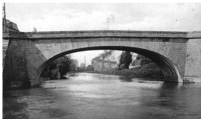
Fig. 5 : Le pont Saint-Edme à Nogent-sur-Seine (Aube), construit par Perronet pour la route royale de Paris à Bâle (RN 19). Devant le précarité d'un ancien pont à quatre arches, pourtant construit depuis seulement une quarantaine d'années, Perronet fit construire un peu plus en aval, d'octobre 1766 à octobre 1768 (décintrement), un nouveau pont d'une seule arche en anse de panier de 90 pieds d'ouverture (29,24 m). Il a été détruit par les Allemands lors de leur retraite, le 26 août 1944 et malheureusement n'a pas été reconstruit à l'identique, un peu plus large certes, mais avec des brisures aux naissances de la voûte.
