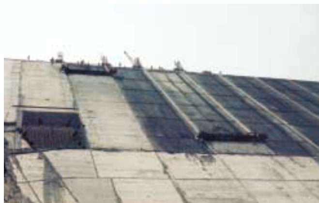
Fig.5 : Construction de l'écran en béton
