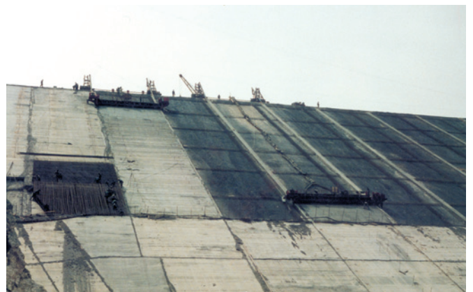
Fig.5 : Construction de l'écran en béton
