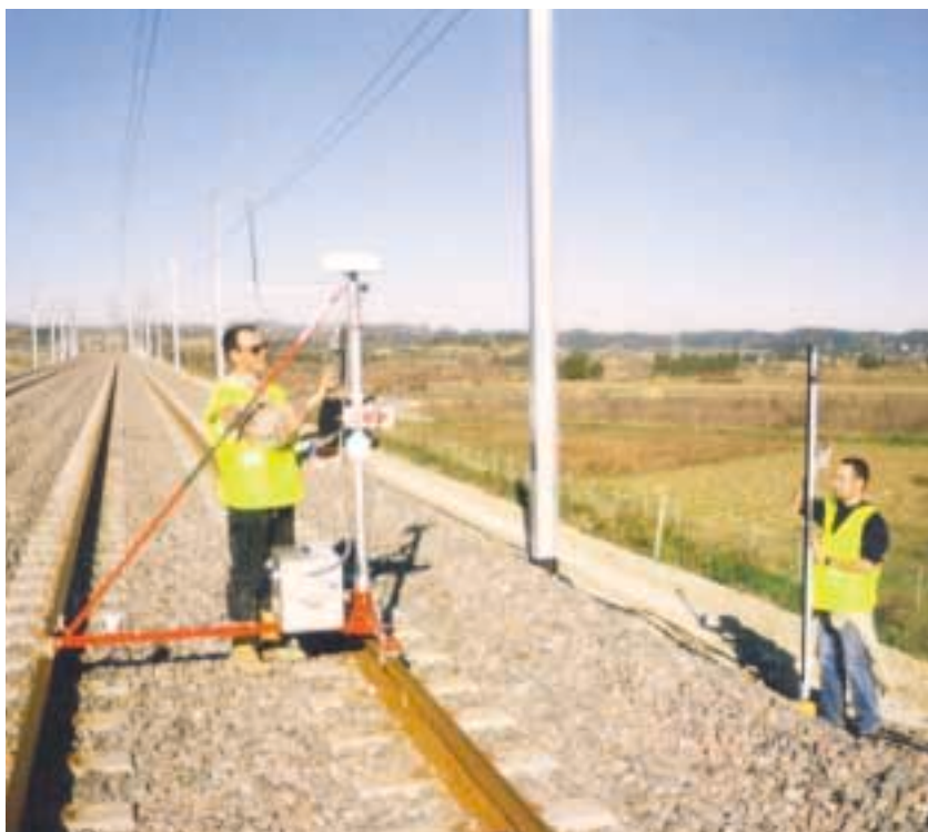
Fig. 6 : Méthodologie de levé d'une borne
