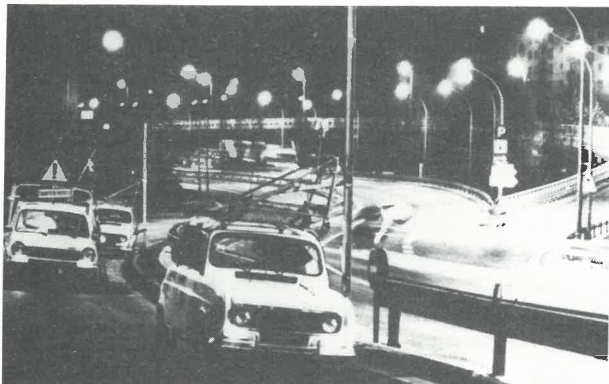
A — Nivellement motorisé sur le périphérique
