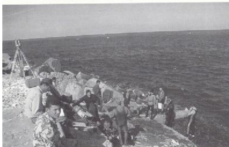
Relevés de blocs immergés du phare antique d'Alexandrie. Dans le cercle, la mire est visible. CNRS
