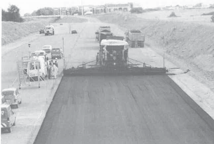
2. Deux capteurs fixés sur des mats télescopiques électriques de chaque côté du screed.
