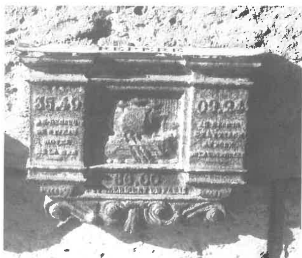
Figure 26 : Repère de la ville de Paris situé sur le parapet du quai de la Tournelle, à l'angle amont de l'entrée rive gauche du pont de l'Archevêché. Nivelé par Bourdalouë en 1858, il lui attribue l'altitude 35,515.
