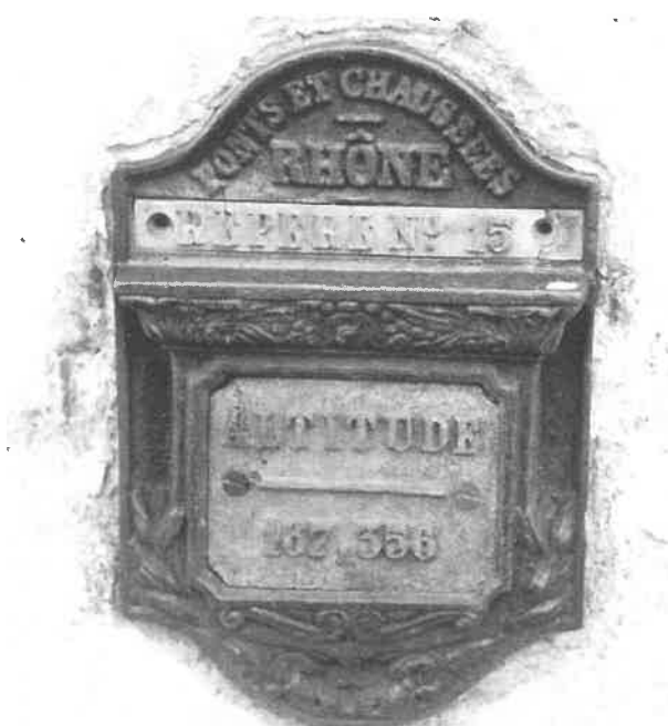
Figure 23 : Repère « Nivellement du Rhône » de la ville de Lyon, sur la prison Saint-Joseph, 12 quai Perrache, avec son indicateur portant l'altitude 167,356. En fait, cette indication est, comme à Vienne, dans la référence du Nivellement général de la France qui ne sera arrêtée qu'en 1862. L'altitude initiale de ce repère, portée dans les répertoires de 1858 est de 167,820, référence Nivellement du Rhône. L'écart de 464 mm est expliqué ci-après dans le paragraphe « Compensation du Nivellement général de la France ».
