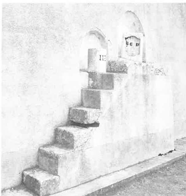
Figure 20 : Les bornes de la Loire, nivelées par P.A. Bourdalouë en 1855. Ici entre Meung-sur-Loire et Saint-Ay (Loiret) sur la rive droite, en aval d'Orléans, la borne repère 66 D et la borne kilométrique 113.
