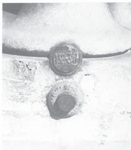
Figure 13 : Un des repères posés à Bourges par Bourdalouë en 1850, toujours en place au pied du meneau du portail central de la cathédrale Saint-Étienne. Son altitude 156,347, portée par l'indicateur scellé au-dessus du repère, est directement déduite de l'altitude 159,360, du repère géodésique (tour nord de la cathédrale) de la méridienne de Paris du canevas de 1 er ordre de la carte d'État-major. Il est ainsi le repère fondamental du nivellement du département du Cher et de la ville de Bourges.
