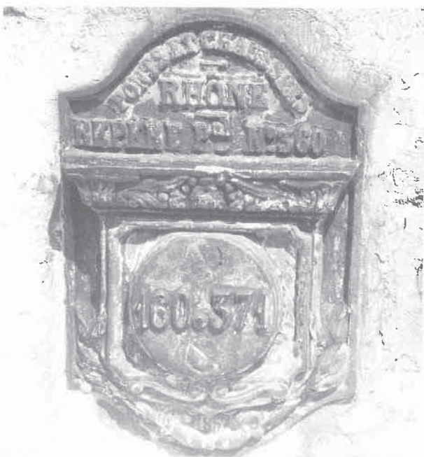
Figure 21 et 22 : Cathédrale Saint-Maurice à Vienne (Isère) et son repère « Nivellement du Rhône » n° 360. On remarque la date 1857 inscrite à la partie inférieure de ce type de repère. L'indicateur circulaire est du modèle adopté en 1858 pour les repères du Nivellement général de la France (voir ci-dessous), ce qui montre qu'il a été rapporté quelques années plus tard et d'ailleurs l'altitude 160,371 est bien dans la référence de ce nivellement, alors que l'altitude dans la référence « Nivellement du Rhône » est 160,830.
