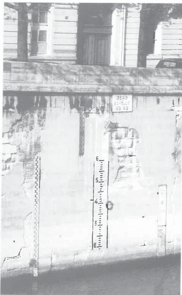
Figure 27 : Échelles du pont de la Tournelle. Le zéro de l'échelle a d'abord été fixé en 1842 par la commission Arago à 26,25 au-dessus du niveau moyen de la mer. Bourdalouë lui affecte l'altitude 26,285. L'altitude 25,62 indiquée actuellement pour le zéro de l'échelle, a été inscrite plus tard dans la référence du Nivellement Lallemand. La grande crue du 28 janvier 1910 a atteint 8,25 au-dessus du zéro.
