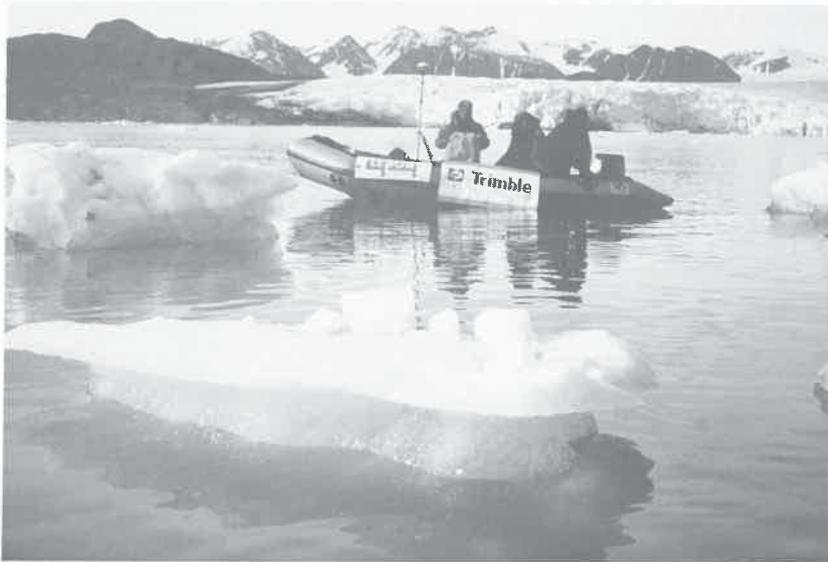
au levé par visée (station optique) ou à la photogrammétrie, mais les coûts de ces techniques sont élevés et le rendement toujours lié aux conditions atmosphériques (brouillard épais très fréquent au Spitsberg). D'où le choix de réaliser ces levés par système GPS, avec l'équipement de la série 4000 de chez Trimble distribué par Le Pont Equipements.
