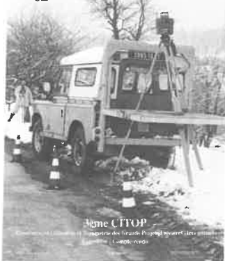
Géodimeter System 4000 au travail. Station robotisée sur trépied de grande hauteur. La plateforme hydraulique du véhicule se déplace et permet d'effec- tuer la mise en station (voir article page 13). Cliché Géotronics.
