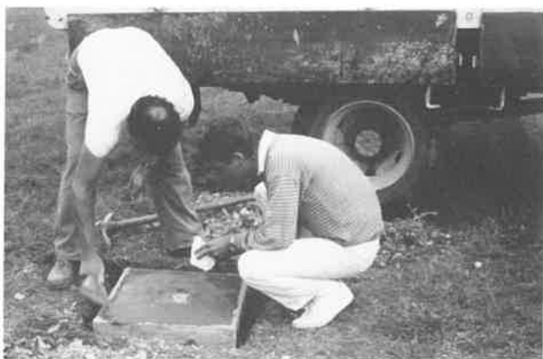
Pose d'un repère d'axe de piste sur l'aérodrome de LOUDUN - photographie de Pierre Bijou
