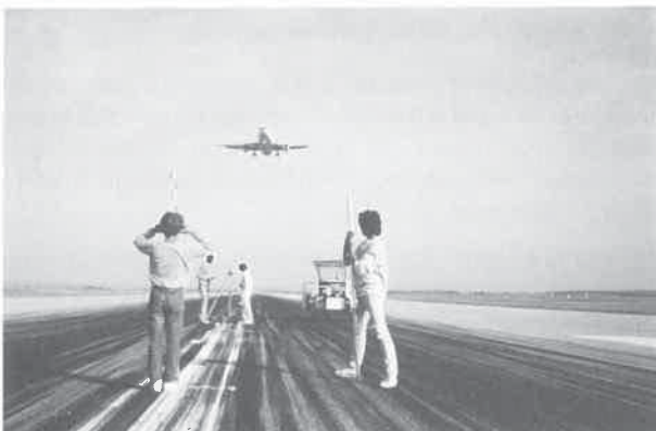
Nivellement de la piste de l'aérodrome de Lyon-Satolas - travail exécuté sous trafic par la cellule topographique - photothèque du STBA
