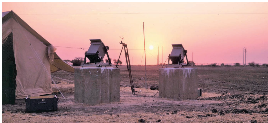
Figure 2. Chambres balistiques IGN - Station de Fort-Lamy (1968)
