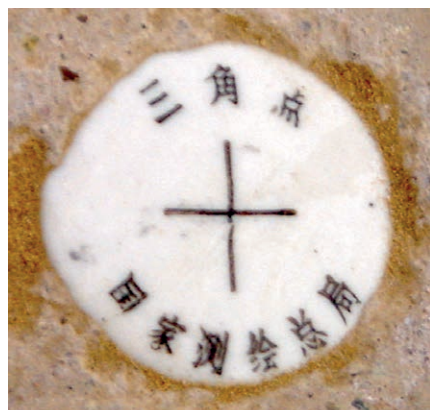
Figure 7. Repère du point géodésique
