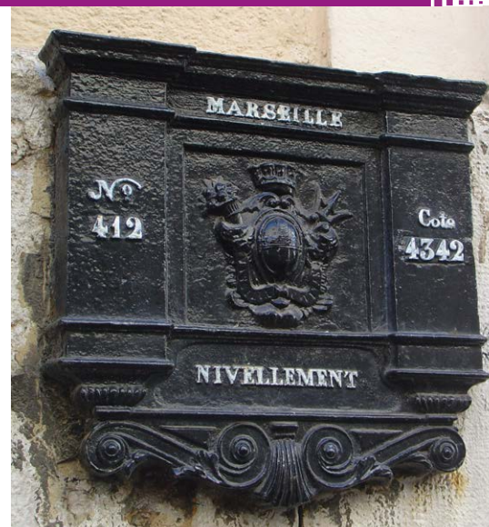
Figure 3. Exemple de plaque-repère à tablette. Celle-ci est scellée à Marseille, au n° 82 rue Blanqui. La tablette est, sur ce modèle, constituée par la face supérieure du repère.
