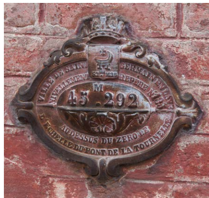
Figure 5. Repère de nivellement scellé au n°32 rue Alexandre Dumas, dans le pilier gauche du portail de la propriété "La Gagnerie". La cote correspond à la tablette qui figure au centre du repère.
