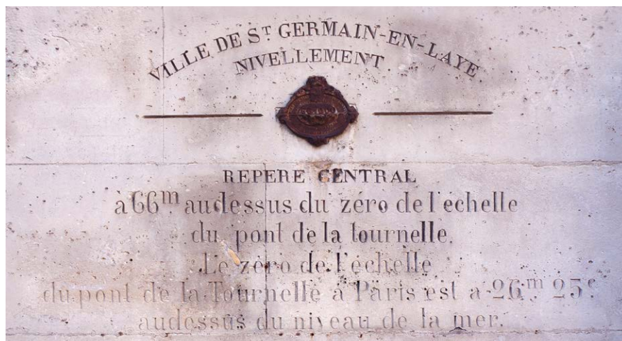
Figure 6. Repère "central", scellé dans le mur de façade nord de l'église Saint-Germain, face à la place de la Paroisse.
