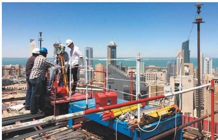
Contrôle des coffrages des murs porteurs à l'aide d'une station totale utilisant les points actifs GNSS - Tour NBK au Koweït
