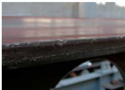
Figure 4. Aperçu des défauts "physiques" pouvant altérer les mesures des arêtes
