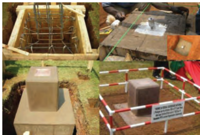
Figure 8. Etapes de la construction des bornes de 1 er ordre
