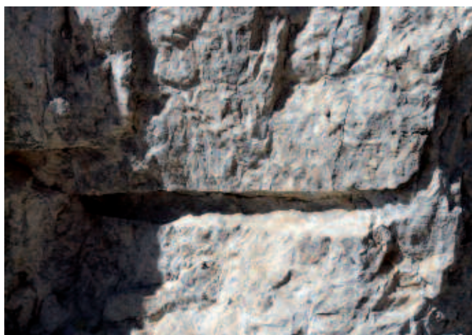
Figure 8. Trou de barre à mine pour le creusement de la Brèche des Moines. Il n'a rien à voir avec un trou pour coin de bois mouillé.
