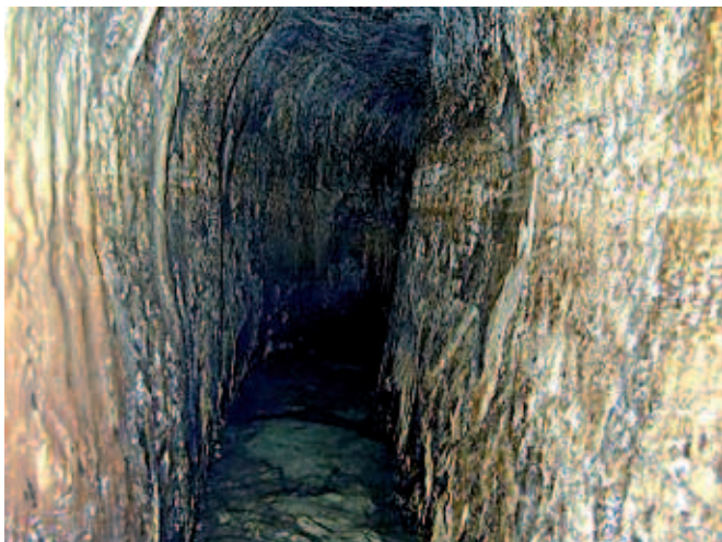
Figure 2. Le tunnel est taillé à la pointerolle et la massette, il a 1,5 m de haut pour 0,6 de large. Les coulées de calcite, visible, ont permis sa datation. Correspond-il à l'élargissement d'un conduit plus étroit ?
