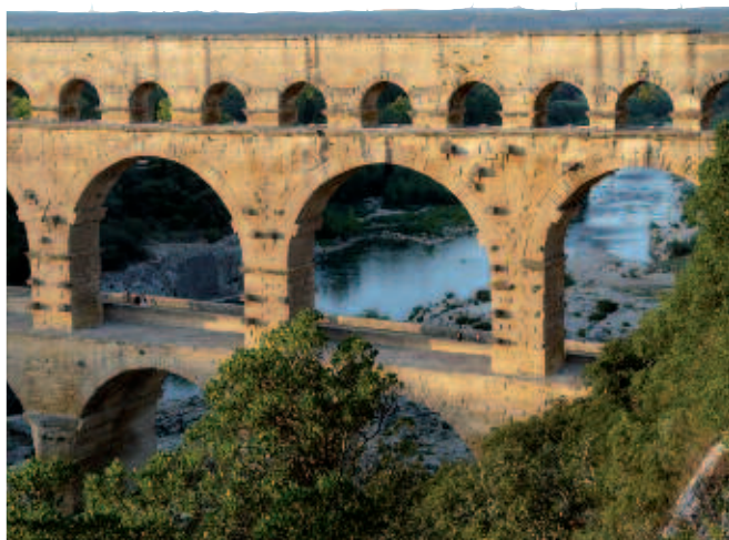
Figure 7. Dominant le Gardon de 49 m aux basses eaux, le Pont du Gard est le plus haut aqueduc romain. La détermination précise des pentes différentes en amont et en aval de l'aqueduc permet d'abaisser sa hauteur de 5 m.
