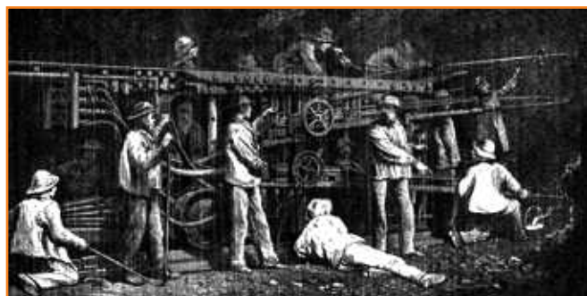
Figure 16. Perforatrice utilisée au tunnel de Fréjus (d'après Edward Wymper en 1873).
