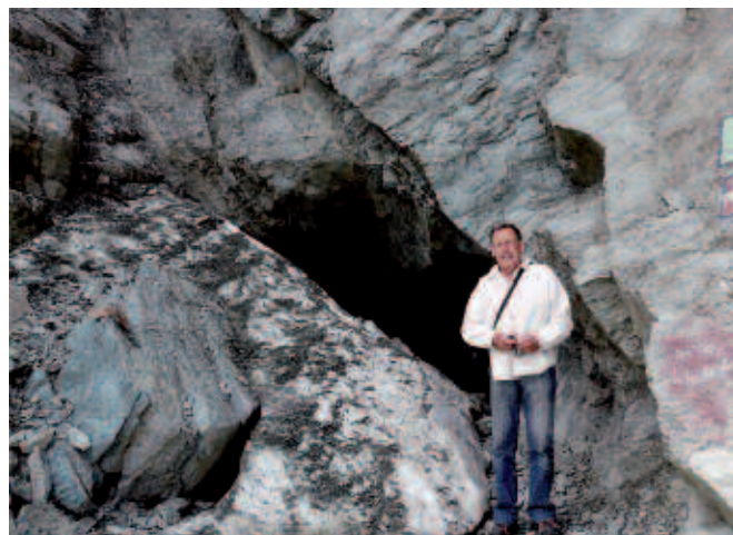
Figure 12. L'entrée du tunnel côté italien. Il a été creusé à la faveur d'une fracture facilitant le travail de la roche.
