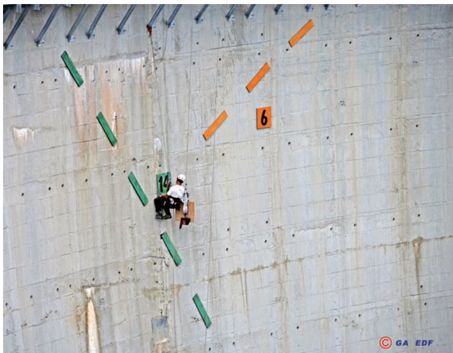
Figure 7. Fixation des plaques de lave émaillée.
