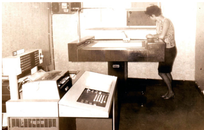
La table traçante Benson 00 associée à un ordinateur IBM 1130. Remarquez la taille de l'ordinateur d'une capacité de 8 Ko ! Pas encore d'écran.
