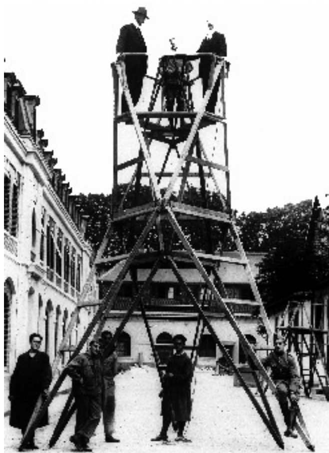
Photographie montrant un tripode Ragué, utilisé en géodésie, monté dans la cour du Service Géographique de l'Armée, 136 rue de Grenelle, avant la création de l'IGN. ■ ■ ■
