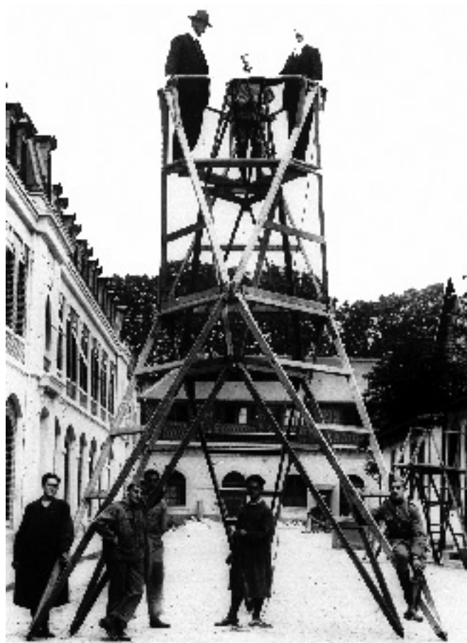
Photographie montrant un tripode Raguette, utilisé en géodésie, monté dans la cour du Service Géographique de l'Armée, 136 rue de Grenelle, avant la création de l'IGN. ■ ■ ■
