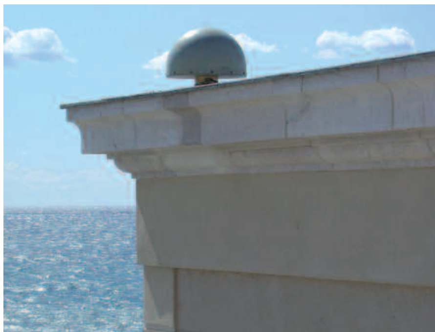
L'antenne de la station RGP installée sur le toit du Marégraphe de Marseille.
