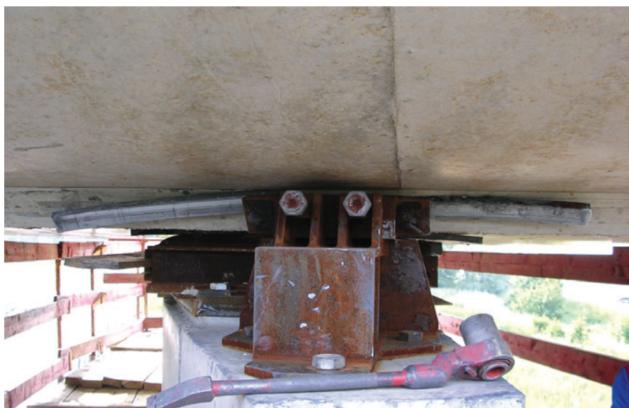
Figure 2 : Dispositif de glissement avec dispositif de guidage
