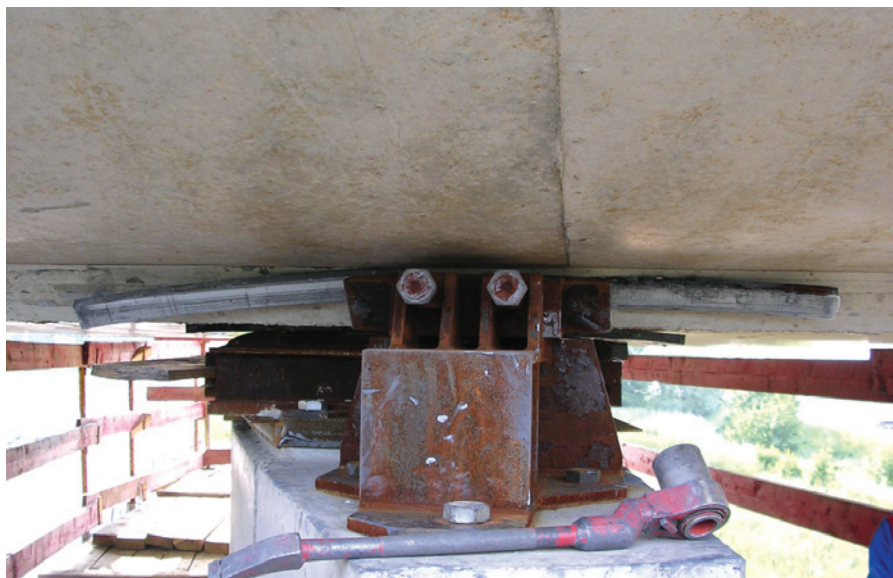
Figure 2 : Dispositif de glissement avec dispositif de guidage
