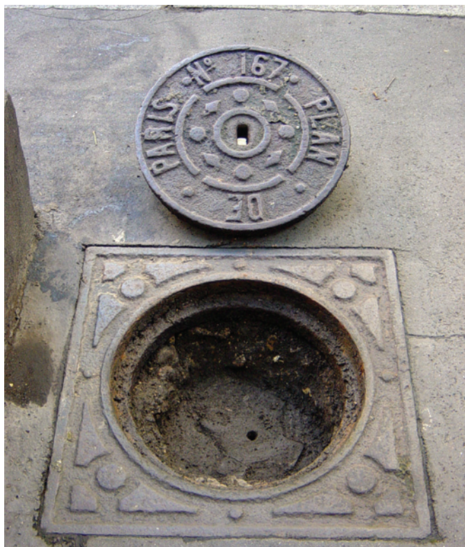
Tampon "PLAN DE PARIS N° 167" ouvert et laissant apparaître la croix après déblaiement de la terre végétale.
