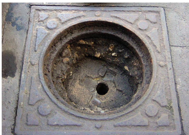
Tampon "PLAN DE PARIS N° 167" ouvert et dégagé de la terre végétale. Emplacement de la croix métallique.
