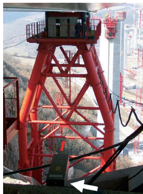
Figure 2 : Principe de la surveillance continue des mouvements transversaux et longitudinaux de la palée pendant lançages à l'aide de télémètres laser.
